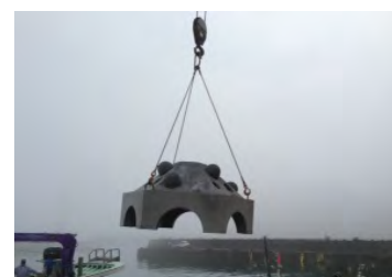
人工魚礁の沈設の様子
