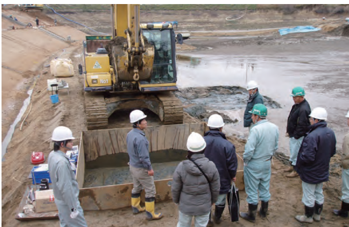
現場でのため池底泥の堤体への活用の研究
